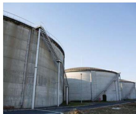
災害時に備え、水道水の貯水をしているPC浄水池。訓練では水漏れがないかなどを点検します。
