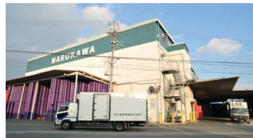
国道1号線沿いにある倉庫建屋。
