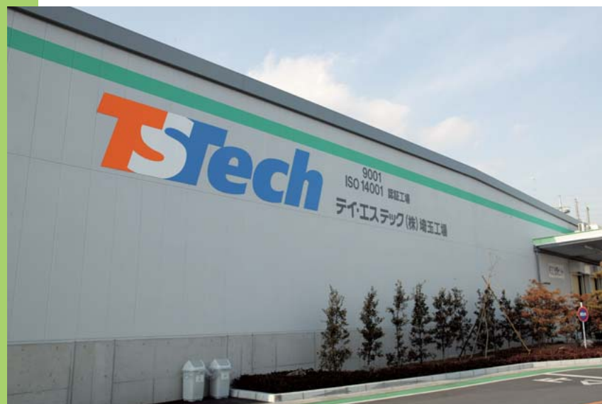
平成16年1月に完成した新工場
