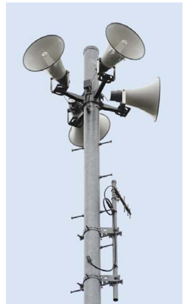
●拡声子局の高所に設置された拡声器。音の到達距離、方向などを計算してスピーカーが設置されています。
