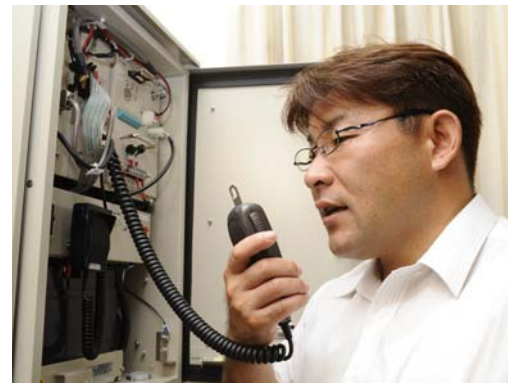
●泉南市総務部政策推進課危機管理係 係長の木津西 博さん。泉南市立桜ヶ丘老人集会場の拡声子局には通信機器を収納した箱が設置され、緊急時には mcAccess e で市役所の親局と情報のやりとりができます。
