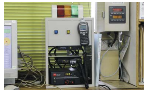
大口顧客に設置された「災害時緊急通報システム」。
