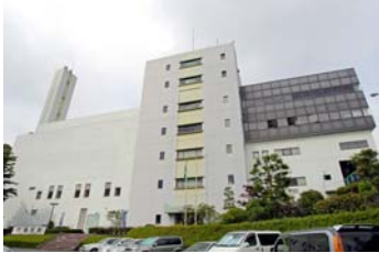
●環境クリーンセンターの建物。この中に ごみピットや焼却炉などがあります。
