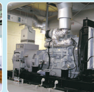
非常用発電装置
